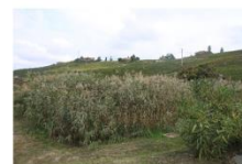
Système Zeofito® avec deux lits plantés sur zéolithe de 80 m 2 chacun installé en 2007 en traitement direct, sans bassin d'aération. Cave GAJA , région du Barbaresco dans le Piémont en Italie. (production annuelle d'environ 700 000 bouteilles)
