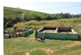
Système Zeofito® de finition en aval de la station « boues activées », cave Banfi, Piémont Italie
